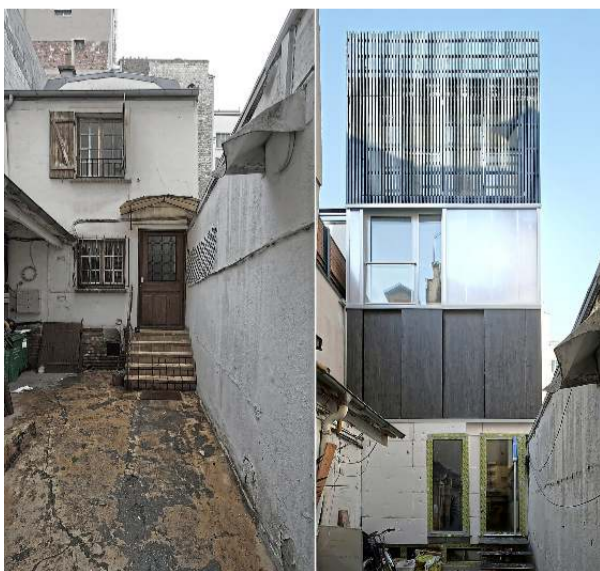
La surface de cette maisonnette de 50 m 2 a été doublée et trois étages ajoutés afin d'y loger un couple et deux enfants.
