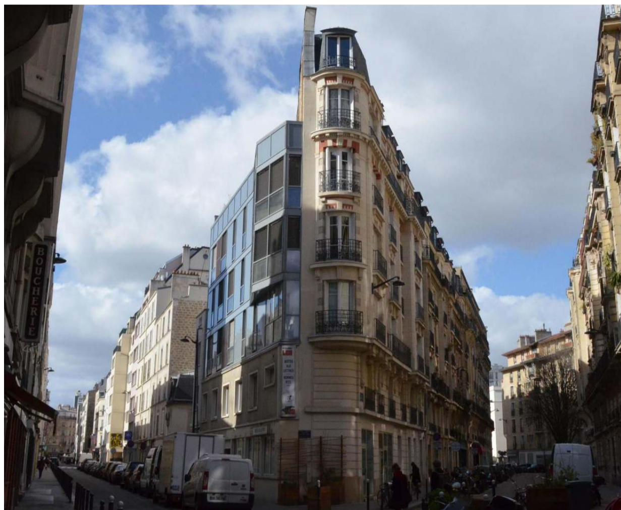
Surélever ce bâtiment situé dans le XIV e arrondissement, à gauche de l'immeuble, a permis de créer trois appartements.
