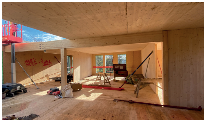
Façades en panneaux ossature bois et murs de refends, plancher intermédiaire et support du toit-terrasse en panneaux CLT sur le projet de la Croix Saint-Simon (Crédits photo : Atelier Choiseul)
