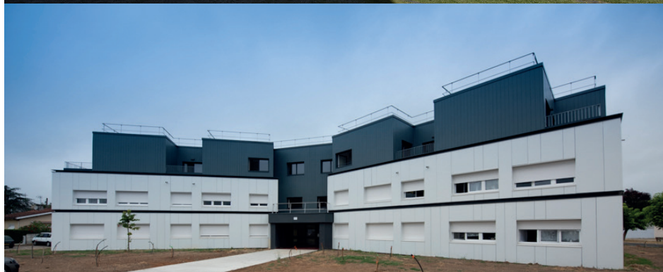
Densification douce , avec une surélévation limitée dans contexte pavillonnaire Crédits photo : Gironde Habitat
