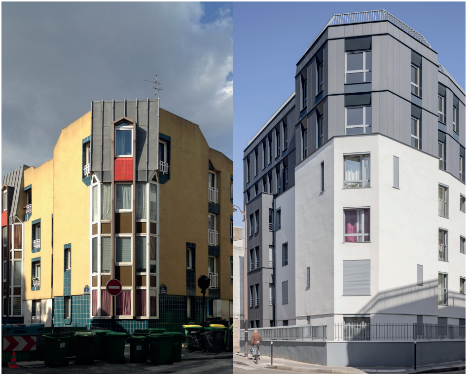
Changement d'image important pour le site de projet , avec une transformation totale alliant rénovation et surélévation Crédits photo : Atelier Choiseul (gauche) Guillaume GUERIN (droite)
