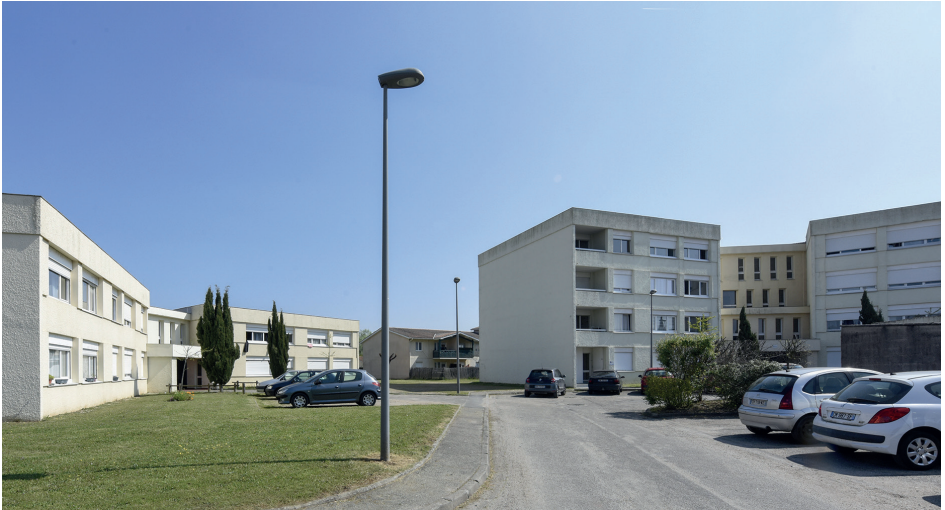
Un site aux multiples potentialités pour la Résidence Canterane , entre espaces extérieurs peu aménagés et faible qualité architecturale Crédits photo : Gironde Habitat
