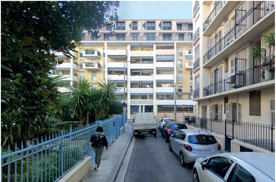
Projet après opération , surélévation permettant de créer 13 logements Crédits photo : UPFA
