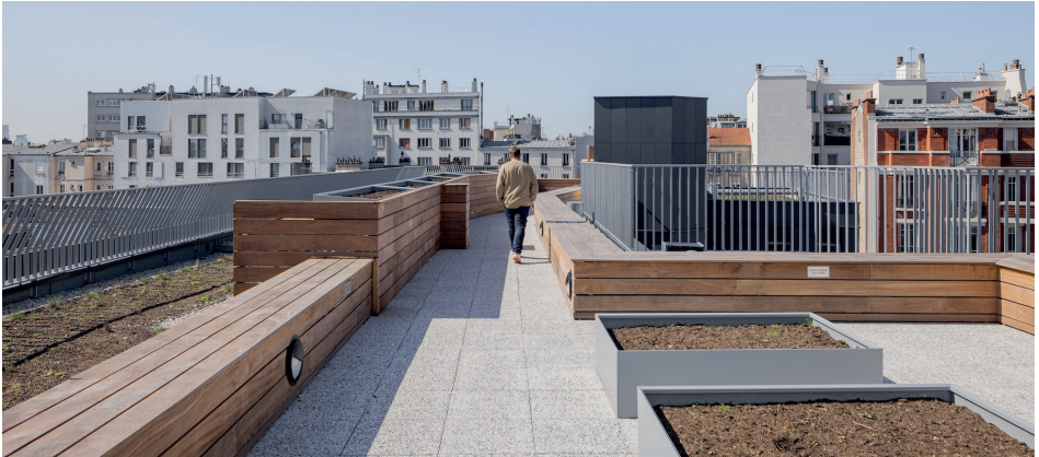
Terrasse partagée sur le toit de l'immeuble , pour les habitants en place et nouveaux Crédits photo : Atelier Choiseul (gauche) Guillaume GUERIN (droite)
