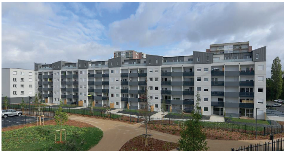
Résidence Mortier à Laval , opération avec intervention en site occupé et ajout d'ascenseur
