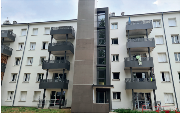
Intégration d'un ascenseur en extérieur pour desservir l'existant aux paliers après modification des volées d'escaliers, résidence La Perrière de Méduane Habitat
