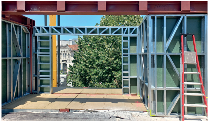
Panneaux ossature métallique pour une surélévation de 3 niveaux sur un rez-de-chaussée à Bordeaux (Crédits photo : Florence Bannier)
