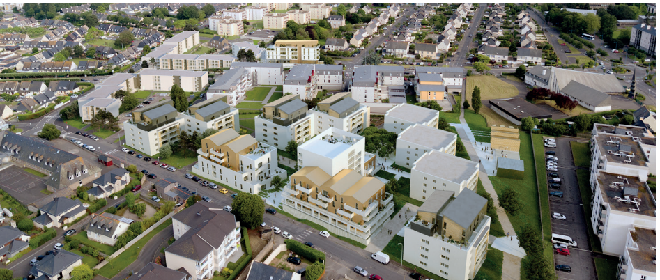
Une métamorphose de l'ensemble du site , par des opérations de rénovation, restructuration, surélévation, densification et démolition Crédits photo : Poltre pour Club
