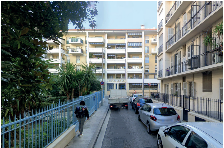
Projet avant opération , logement collectif protégé par l'ABF
